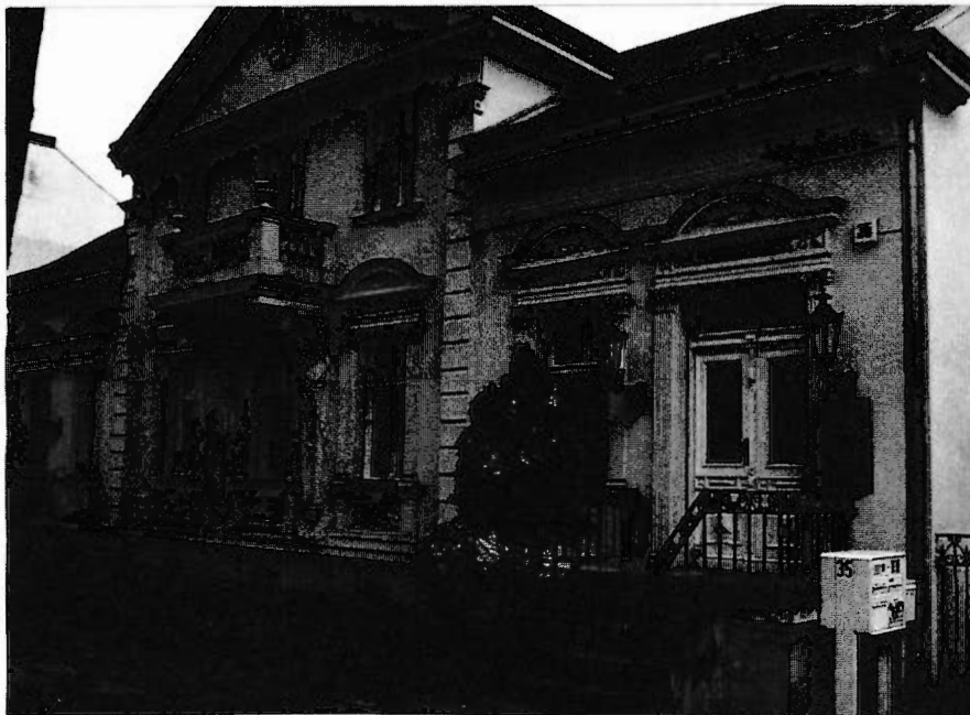
Alt-Karow 35 Wohnhaus um 1890 erbaut, unter Denkmalschutz
